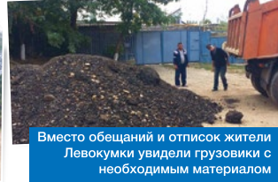
Асфальтовая крошка разгружена для грейдирования дороги (сентябрь 2016 г.)
